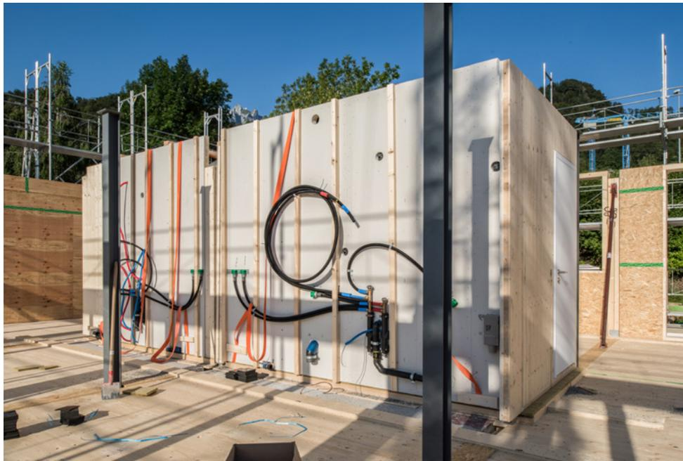
**Kernelement jeder Wohnung ist die Nasszelle, die gleichzeitig die Haustechnik mit Heizung, Kühlung und Lüftung beinhaltet.**
