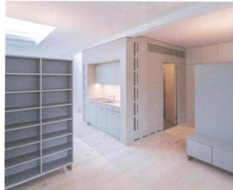
Die vorgefertigte Küchen-Bad-Box. Durch die Schlitz strömt die Luft zum Heizen oder Kühlen der Wohnung.
